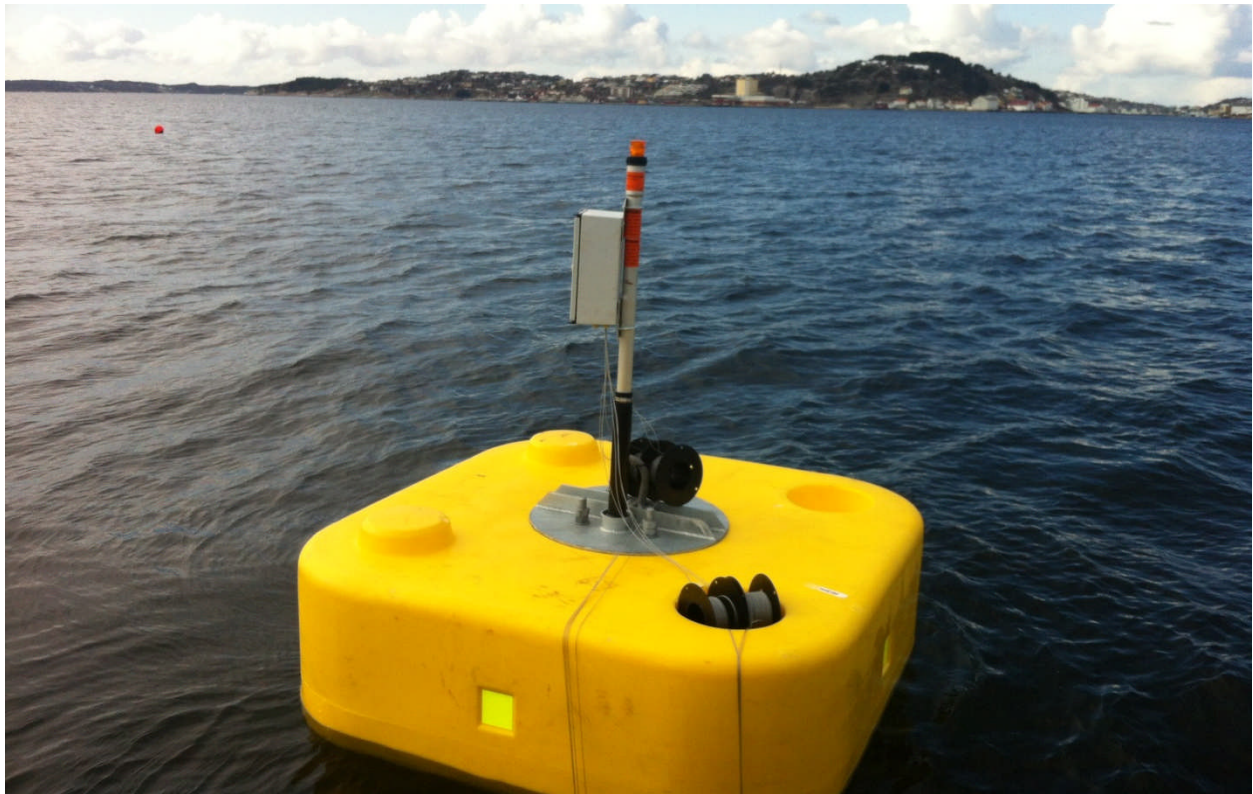
Fig. 6 – Exempel på fjärravläsning vid övervakning av porttryck nära ett hamnbygge. Gateway installerad på en boj för kommunikation via mobiltelefonnätet. Gör inställningar och hämta data via Internet. Ställ in gränsvärden och få lammeddelanden via SMS eller e-mail.
